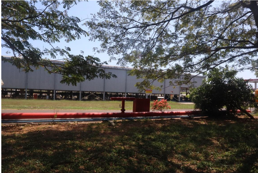
Gambar 15 Area Pemantauan Rumah Pompa
