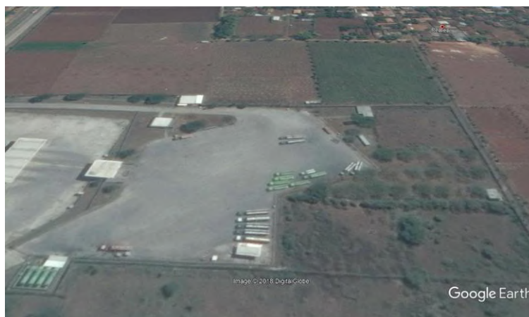
Gambar 1. Gambar citra satelit ( Google Earth ) salah satu lokasi pengamatan, yaitu area Filling Shed
